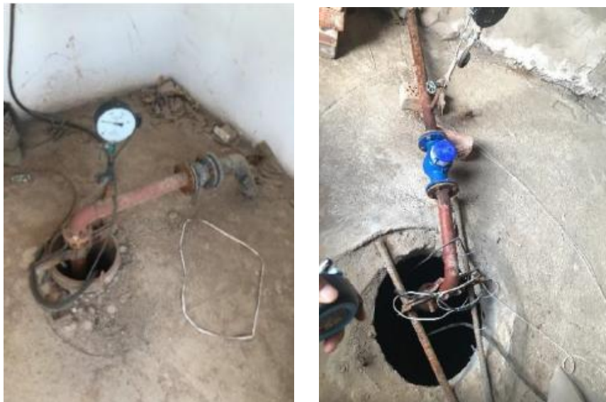
图 1.2.4-8 工业取水井现状
