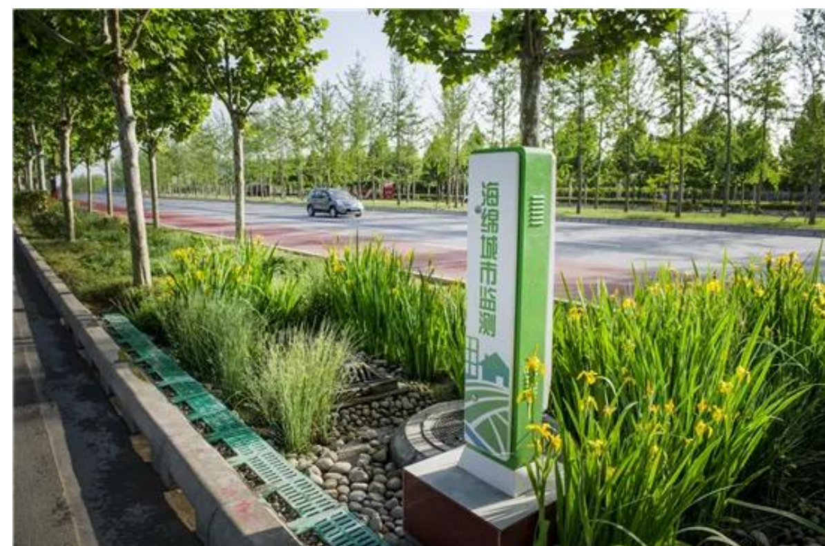
图 5-22 道路绿化带海绵设施
