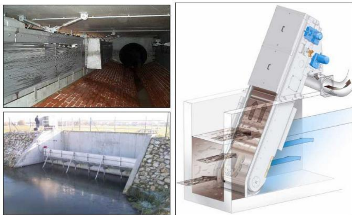
图 5-26 拦渣设施示例图
