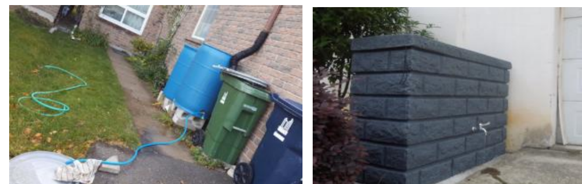
图 5-17 屋面雨水收集设施
