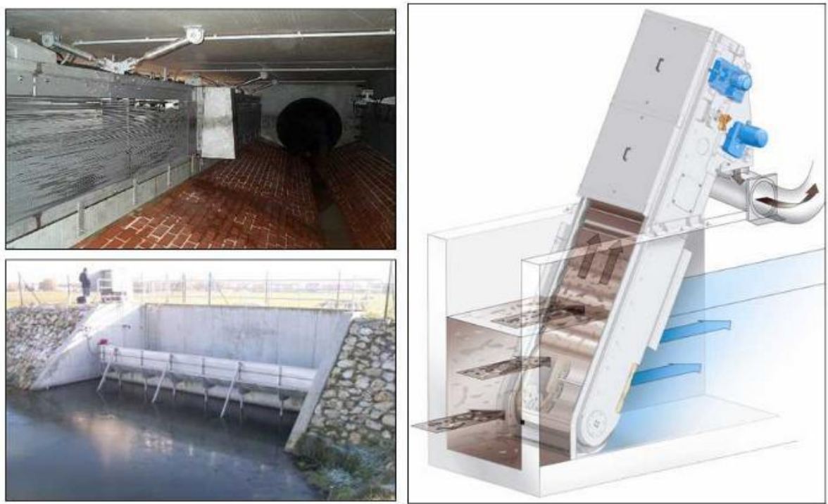
图 5-26 拦渣设施示例图
