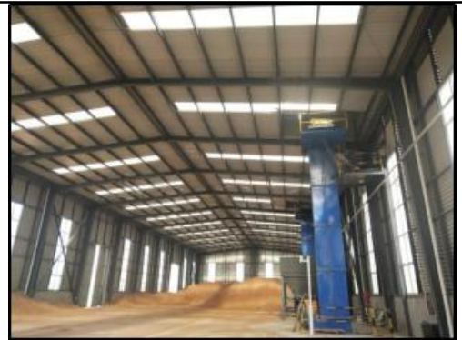
全封闭原料库
